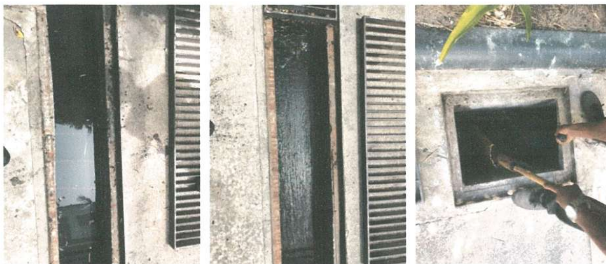
รูปภาพที่ 2.61 การขุดลอกตะกอน
