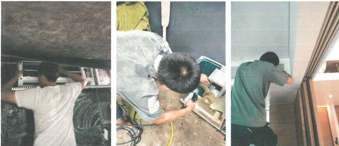
รูปภาพที่ 2.43 การทำความสะอาดเครื่องปรับอากาศ/ถาดรองรับน้ำ และอุปกรณ์ระบายอากาศ
