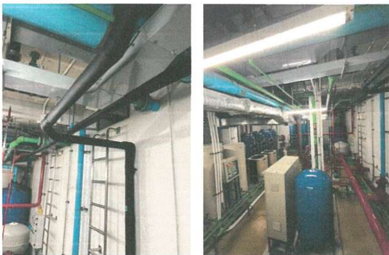
รูปภาพที่ 2.10 ถังเก็บน้ำใต้ดินและระบบกรองน้ำใช้
