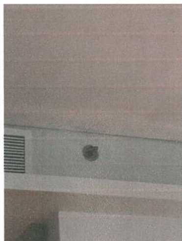
ระบบหัวกระจายน้ำดับเพลิงอัตโนมัติ
