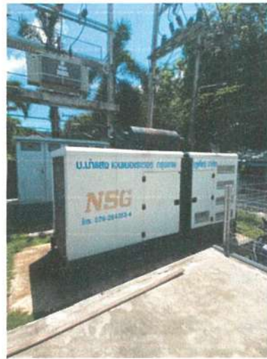
รูปภาพที่ 2.12 เครื่องกำเนิดไฟฟ้าสำรอง
