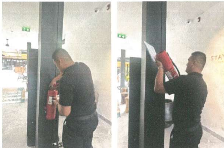
รูปภาพที่ 2.37 การตรวจสอบระบบป้องกันและระงับอัคคีภัย
