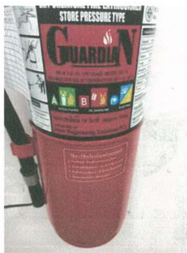
รูปภาพที่ 2.55 ป้ายวิธีการใช้ อุปกรณ์ดับเพลิง
